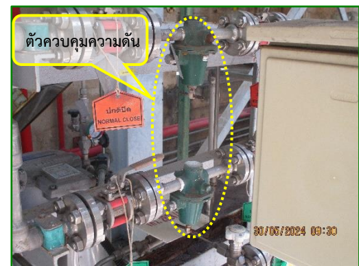
ภาพที่ 2.40 การติดตั้งระบบป้องกันและควบคุมความดันของถังแอมโมเนีย
