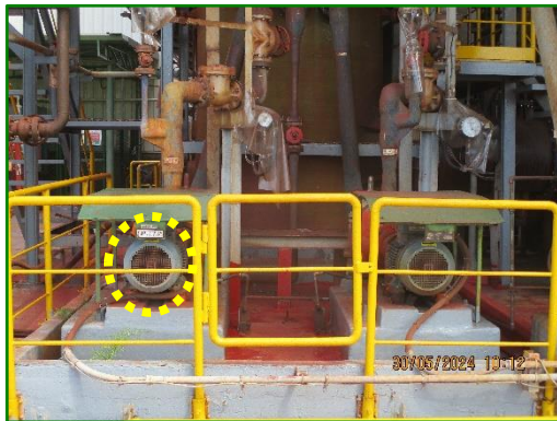
ภาพที่ 2.4 เครื่องสูบน้ำสำหรับไอกกรดของ Scrubber
