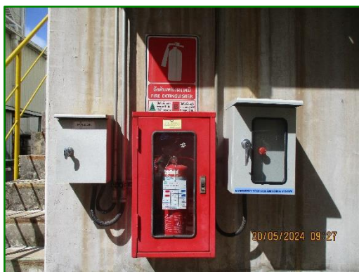
ภาพที่ 2.39 ถังดับเพลิงชนิดผงเคมีแห้งบริเวณพื้นที่จัดเก็บแอมโมเนีย
