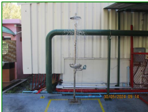
ภาพที่ 2.31 การติดตั้งฝักบัวฉุกเฉินและอ่างล้างตาฉุกเฉินภายในโครงการฯ
