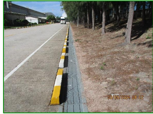
ภาพที่ 2.12 รางระบายน้ำฝนรอบพื้นที่โครงการฯ
