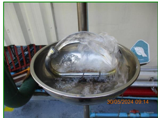
ภาพที่ 2.31 การติดตั้งฝักบัวฉุกเฉินและอ่างล้างตาฉุกเฉินภายในโครงการฯ
